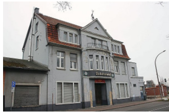
Ein Baudenkmal: der Schützenhof, eine im Ursprung 1888 errichtete Gastwirtschaft. Foto: Jörg Pastoor
