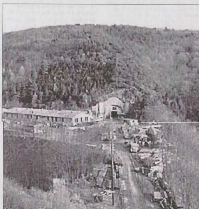
Blick auf das „Lager Rebstock“ samt der dazugehörigen Baracken am Tunnelleingang bei Marienthal. REPRO: BBR
